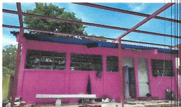
Foto 2: MÓDULO 1 TECHADO DE PATIO
