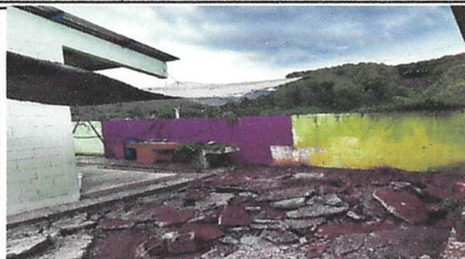
Foto 1: MÓDULO 1 DEMOLICION SEGMENTOS DE LOZA
